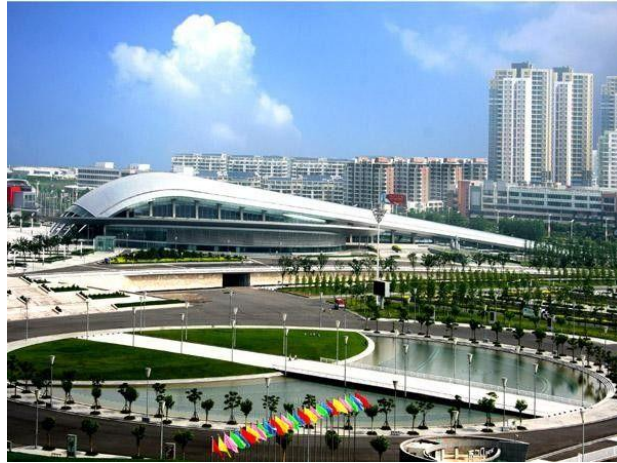
Gambar 19 : Bangunan Baja Komersial Industri Berat Modern di Natatorium di Gimnasium Zhejiang, China.
