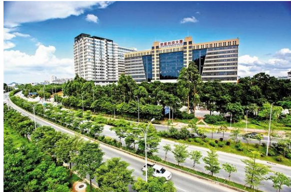
Gambar 12 : Penghijauan pada sepanjang jalan menyeimbangkan pembangunan fizikal kawasan industri.
